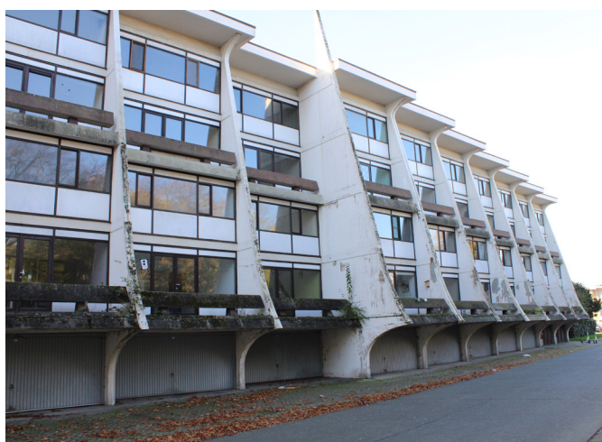
Door het weghalen van de garagepoorten zal de transparantie worden hersteld, vergroot.
